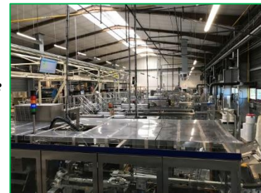
Bâtiment de production
